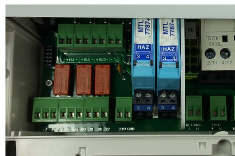
Abb. 2 Stück Zenerbarrieren in 2-Pumpen - mit Trennplatte -
